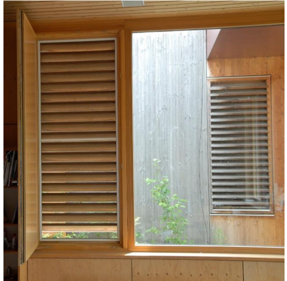
Nachtlüftungsöffnung Albert-Schweitzer-Schule, Foto: ABI, Abteilung Energiemanagement
