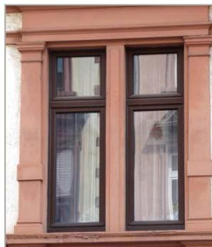
Bild 3: Fensterteilung durch Wandkonstruktion
