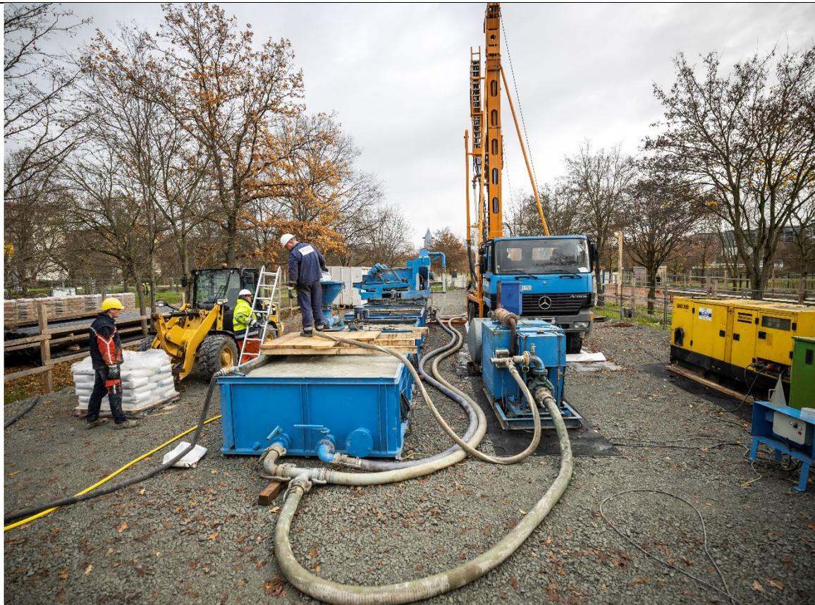
Bohrmannschaft der Fa. Daldrup mit Bohrgerät B3 und Bohrspülung Quelle: Energiereferat / Foto: Hannes P. Albert
