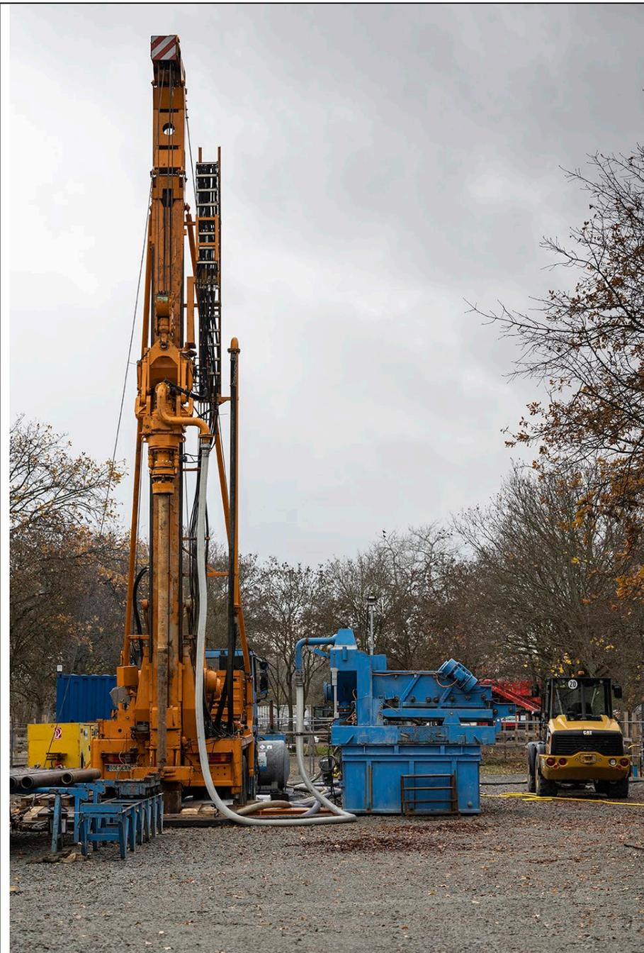
Bohrgerät mit Schüttelsieb für das Bohrklein. Quelle: Energierreferat / Foto: Hannes P. Albert
